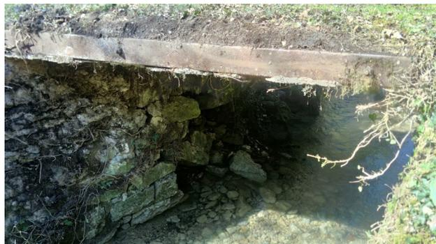
L'employé communal a dégagé le pont sur la Mandorne sur le chemin communal « Allée des Moulins » à Colognat, ce qui nous permet de constater une dégradation du mur de soutènement.
