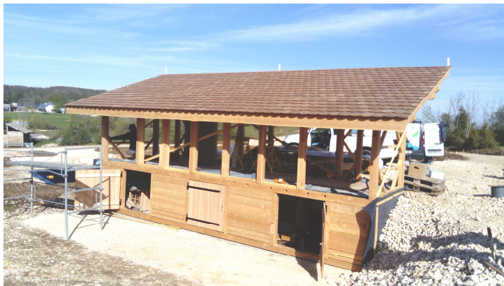
Bâtiment des toilettes sèches en construction.
